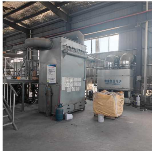
熔炼废气布袋除尘器
