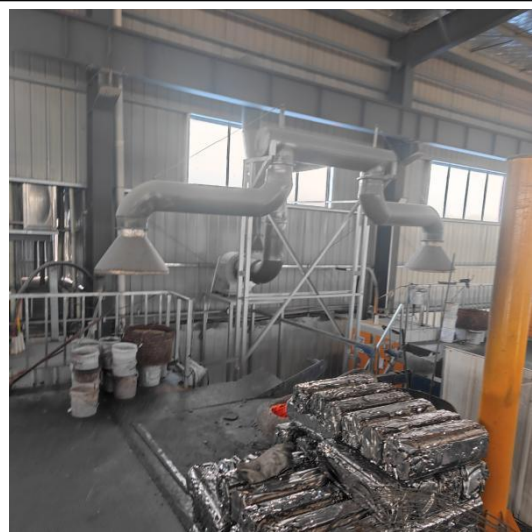
熔炼废气集气罩
